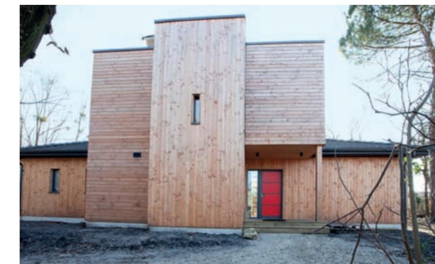
Les magnifiques menuiseries Bois/Alu, équipées d'un double vitrage à très basse émissivité avec lame d'argon, grise côté extérieur et en Pin côté intérieur, l'utilisation de tuiles plates en terre cuite grise, les avant-toits traités dans la même couleur et le profil du bardage en Douglas du Limousin viennent souligner l'architecture contemporaine de la maison.
